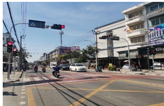
ติดตั้งสัญญาณไฟจราจรหน้าโรงเรียน
