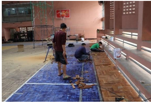
ซ่อมแซมพื้นโรงยิม
